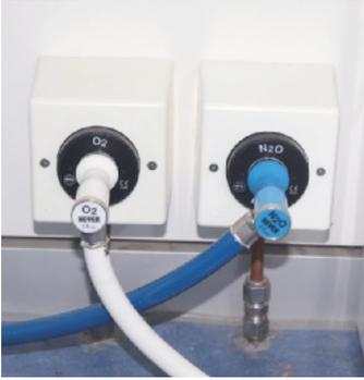
**Abb. 4.3-4** Zentrales System für Lachgas und Sauerstoff, das über verschiedene Adapter eine Verwechslung ausschließt.
